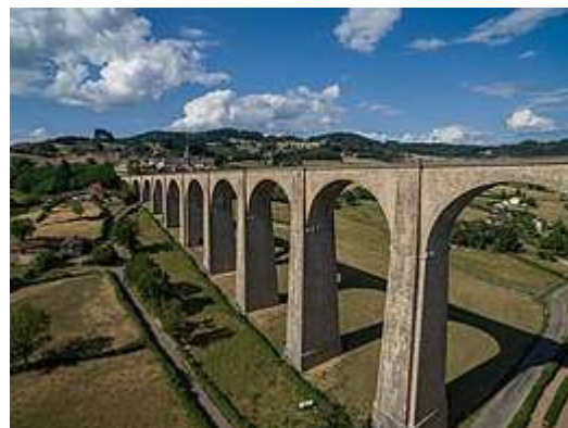
Viaduc de Mussv
