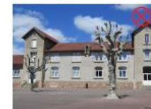
Cour d'école très bitumée générant un îlot de chaleur et avec des arbres en difficulté à Chauvaillies.
