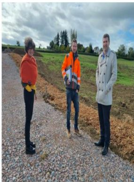
Fabienne Bajard (chargée de mission à Brionnais Sud Bourgogne) Jean-Sébastien Deborde (Ingepro) et Arnaud Durix (vice-président de Brionnais Sud Bourgogne, en charge du développement économique). Les premiers travaux de viabilisation ont démarré en septembre, sur le parc d'activités de la Gare. Photo Noémi Predan
