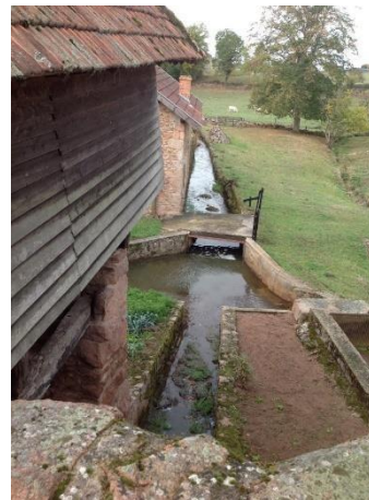
Petit canal d'alimentation en eau à Gibles
