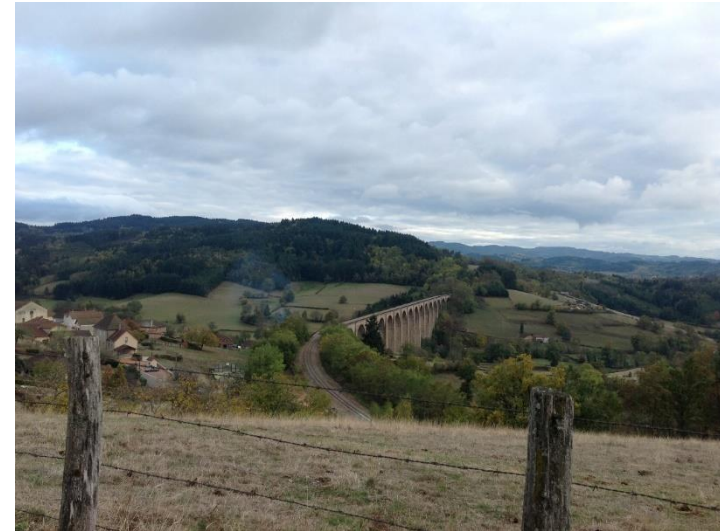
Viaduc vu depuis Mussy/Dun
