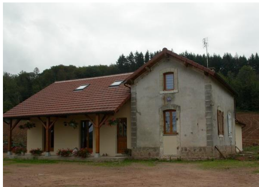
Gare à Gibles à Bois-Sainte-Marie
