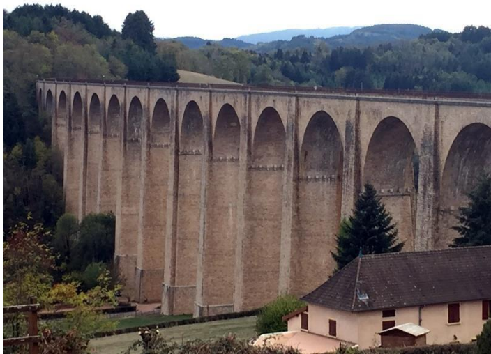
Le Viaduc ferroviaire, Monument Historique protégé
