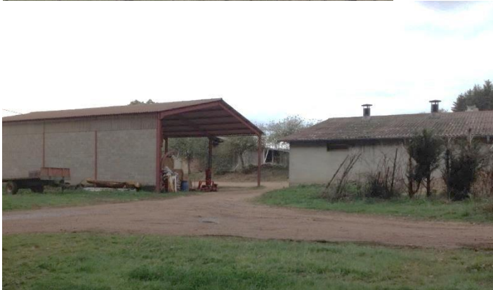
Châtenay - Bâtiments en parpaings non enduits
