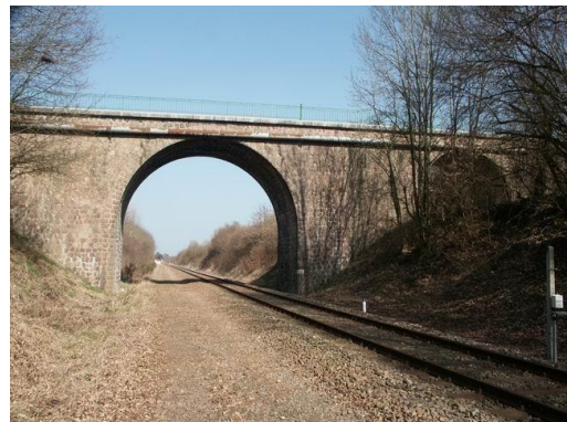
Pont à Curbigny
