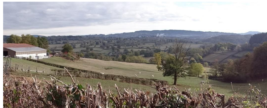
Dyo - Bâtiment au volume bien intégré mais au soubassement clair très visible
