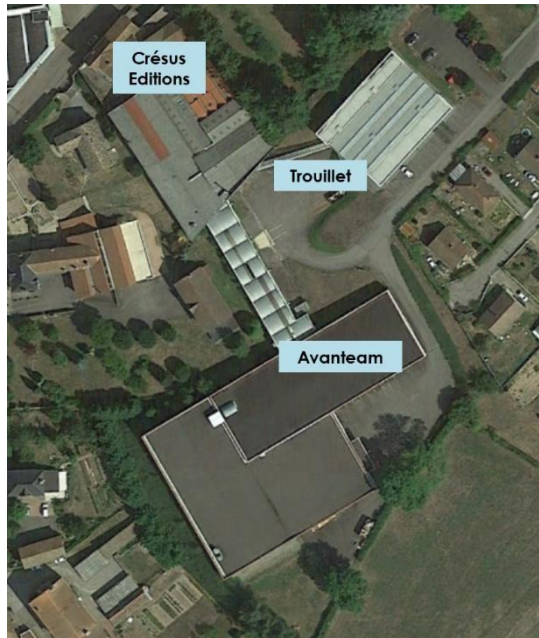
Chemin des Butteries - Av. Charles Rousset
