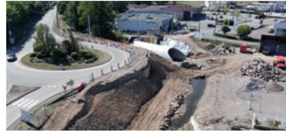
Remplacement de l'ouvrage sous la voie qui s'affaissait et aménagement du lit et des berges du Botoret pour restaurer la continuité écologique et éradiquer la renouée du japon à Chauffailles.
